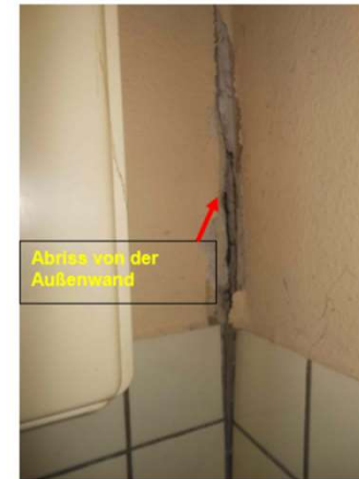
Bild 4 Abriss von der giebelseitigen Außenwand Schadensstelle: Bühnennebenraum links im EG
