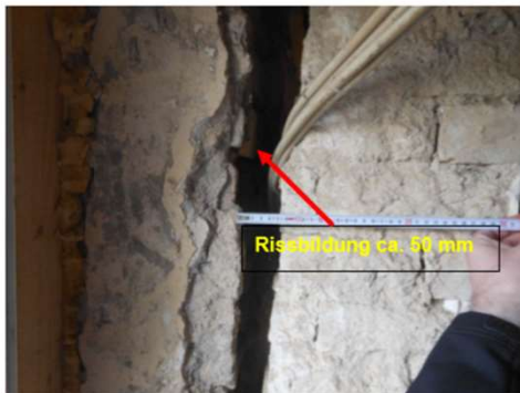
Bild 3 Abriss der giebelseitigen Außenwand von der Innenwand Schadensstelle: ehem. Umkleide unter der Bühne im Souterrain
