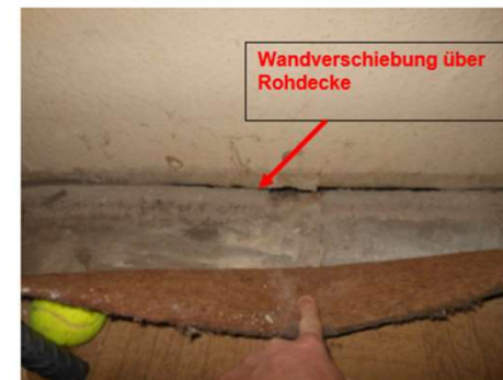
Bild 5 Abriss Fußbodenaufbau Schadensstelle: Bühnennebenraum links im EG
